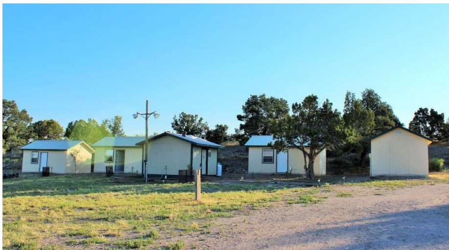
Cabins—Recent New Construction
